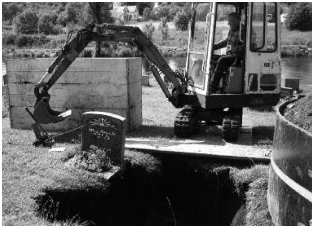
Utfordrande gravearbeid for vår dyktige gravar.
